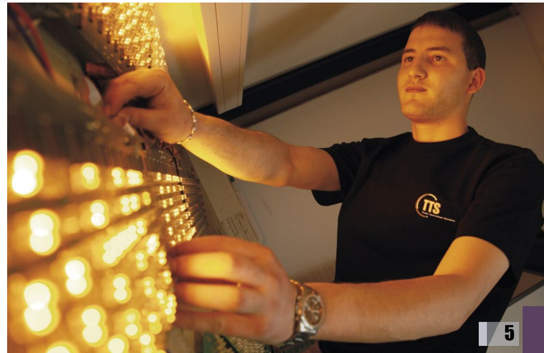
Unité de mise en service & S.A.V
